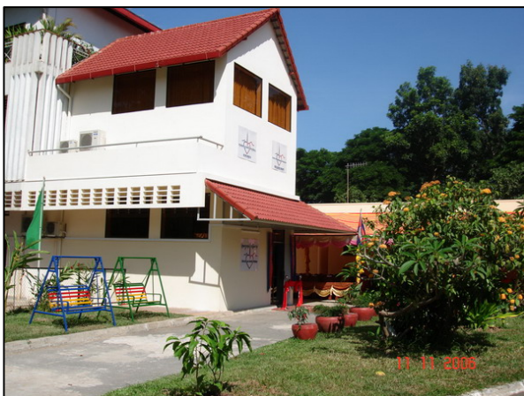
USIC, vue extérieure
